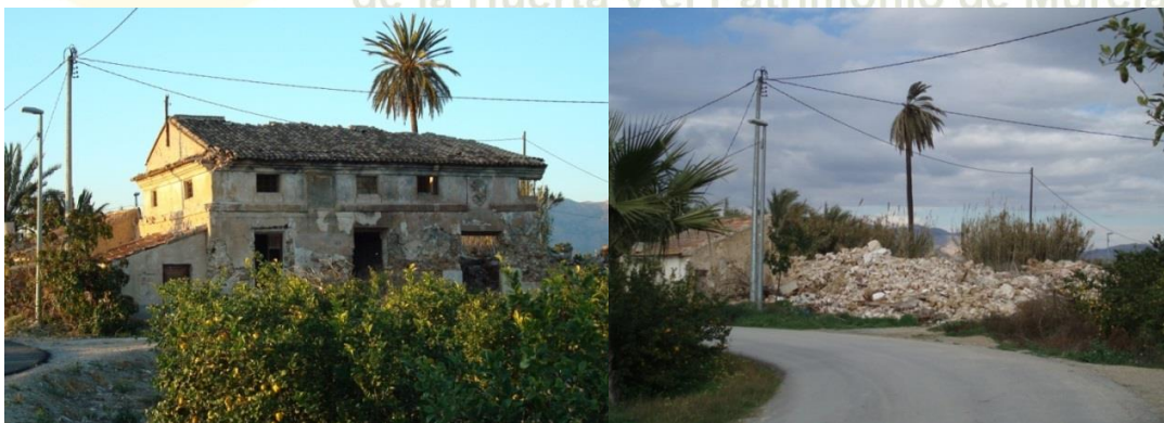
El edificio protegido legalmente, antes y después de ser derribado (Casa-Torre Casa Grande)
