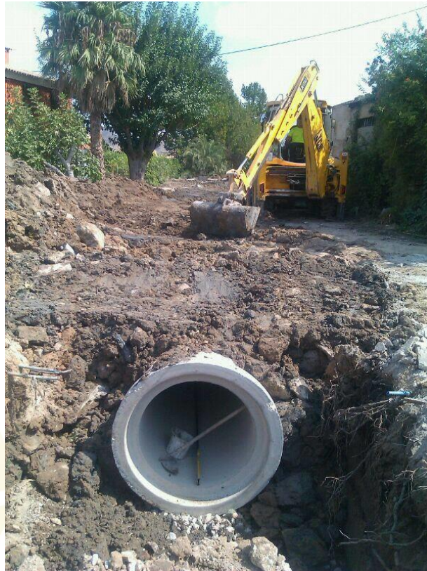
Entubamiento de una acequia de la huerta de Murcia
