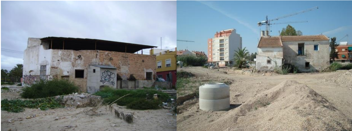
Los molinos del Amor (izquierda) y del Batán (derecha,) entre escombros.
