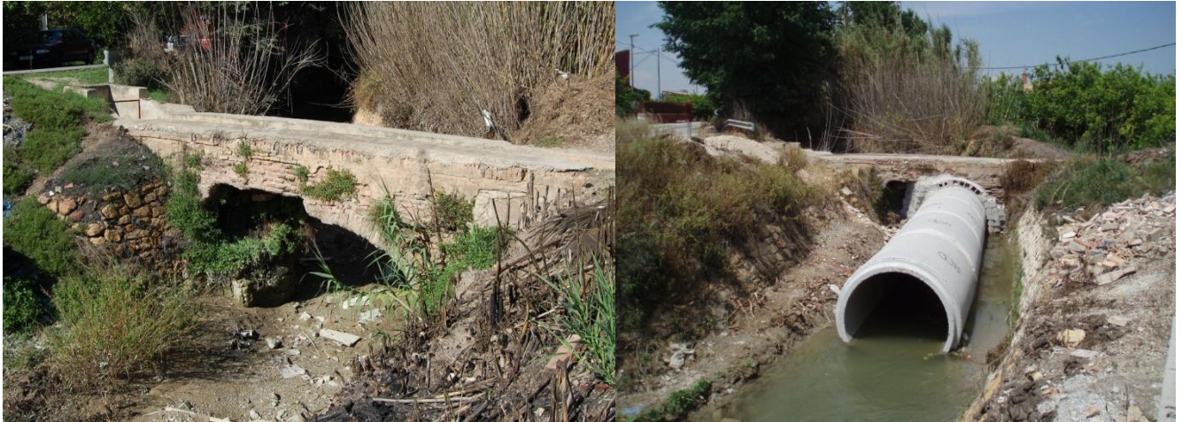
Acueducto del Canal de Torres, en 2010 (izquierda) y en 2011 (derecha).
