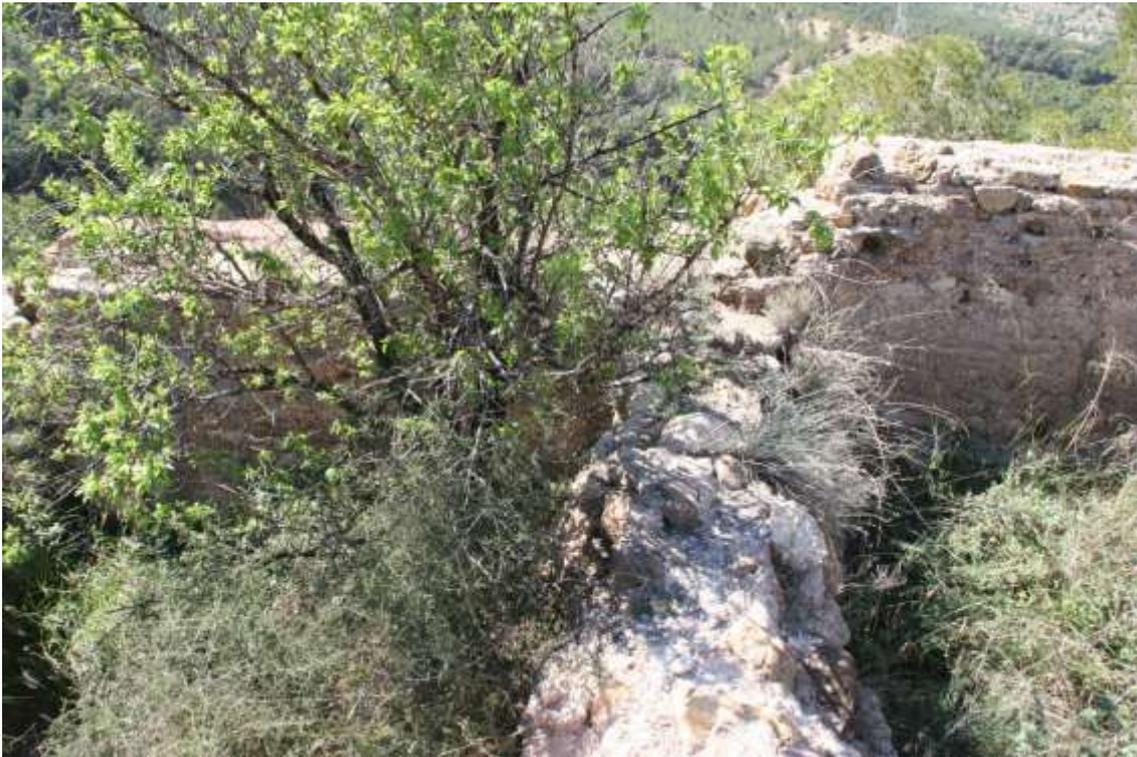
**La falta de mantenimiento de este castillo está provocando que las raíces de los árboles degraden los delicados muros árabes.**
