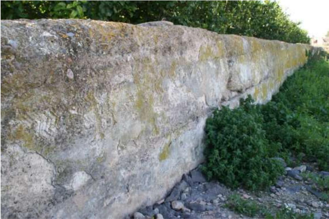
**Detalle de los muros de la alberca, los cuales presentan un estado deteriorado, sin medidas de consolidación y mantenimiento.**
