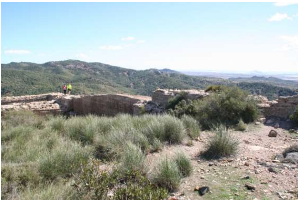
Aspecto de abandono y deterioro en el recinto interior y zona exterior de la fortaleza medieval.
